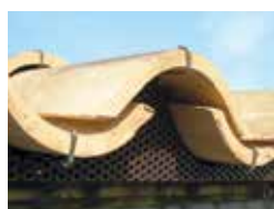
Grille métallique bas de versant T 235
