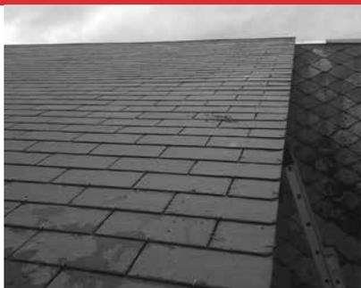
Le système **ONDULINE® AR** est destiné à la réalisation de couvertures en ardoises naturelle de qualité 1, 2 ou 3, ou de l'ardoise fibres-ciment.
